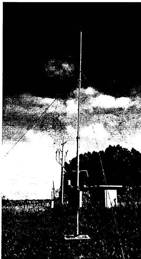
Figura 5. Estação Climatológica automática instalada na Universidade Estadual do Paraná/Campus 2 – Campo Mourão.
