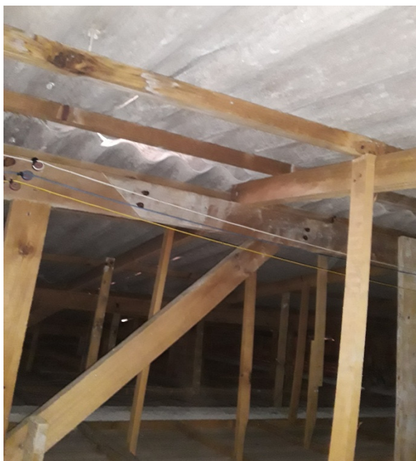
Figura 10 – Vista interna do entreferro do telhado da sala 34
