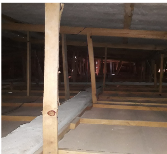
Figura 8 – Vista interna do entreferro do telhado da sala 34
