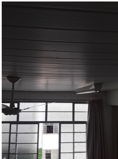
Figura 16 – Forro de PVC da sala 33
