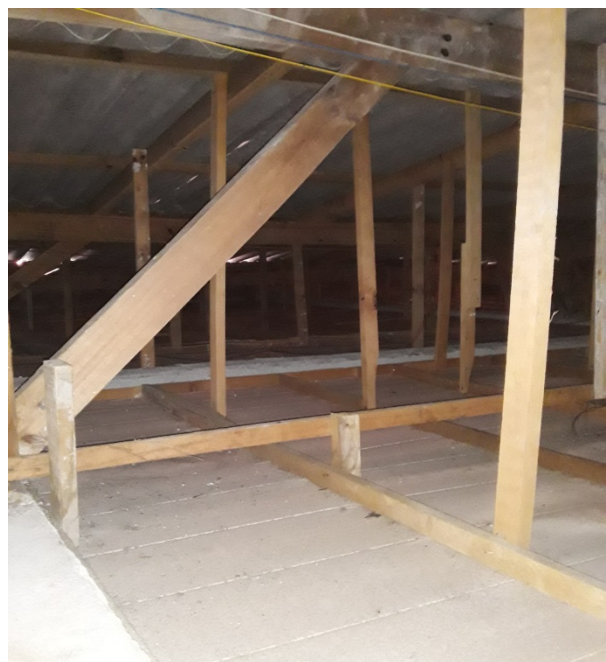
Figura 9 – Vista interna do entreferro do telhado da sala 34. Observa-se na foto, pontos de luz entre as telhas, onde não há encaixe pleno.
