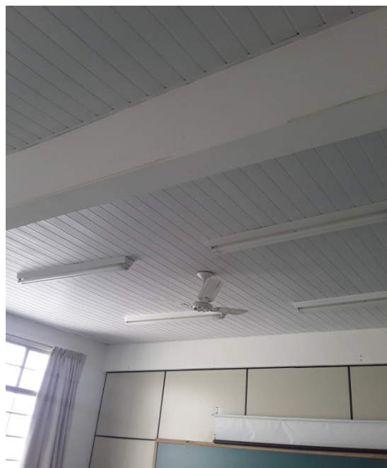
Figura 14 – Forro de PVC da sala 33
