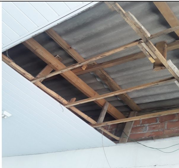
Figura 3 – Trecho do teto da sala 36
