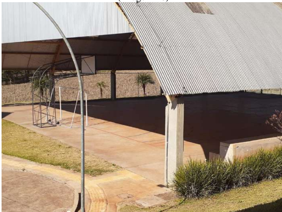
(Quadra coberta – CEEP)
