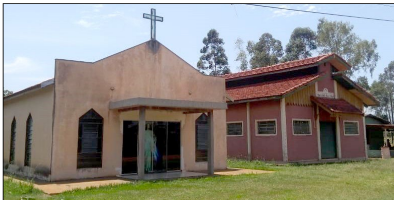
“Centro Comunitário” da Vila Rural Quatro Marcos. Da esquerda para a direita na foto ficam o templo católico, o galpão de artes e ofícios e o bar-mercearia da família Lira.
